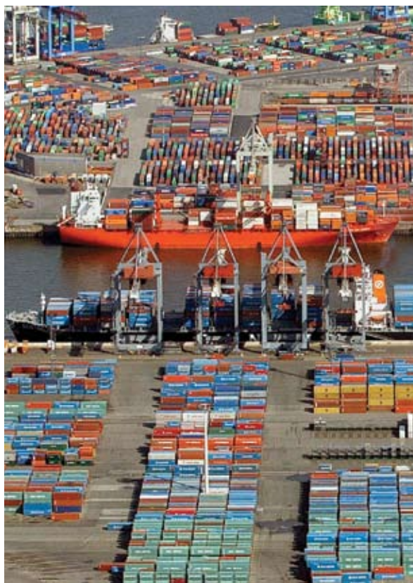
Muelle de contenedores, Hamburgo, Alemania.
