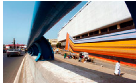
Construction d'un pont d'autoroute à Dakar au Sénégal, où les autorités entendent débloquer l'engorgement de l'infrastructure (photo: Djibril Sy/Panapress)
