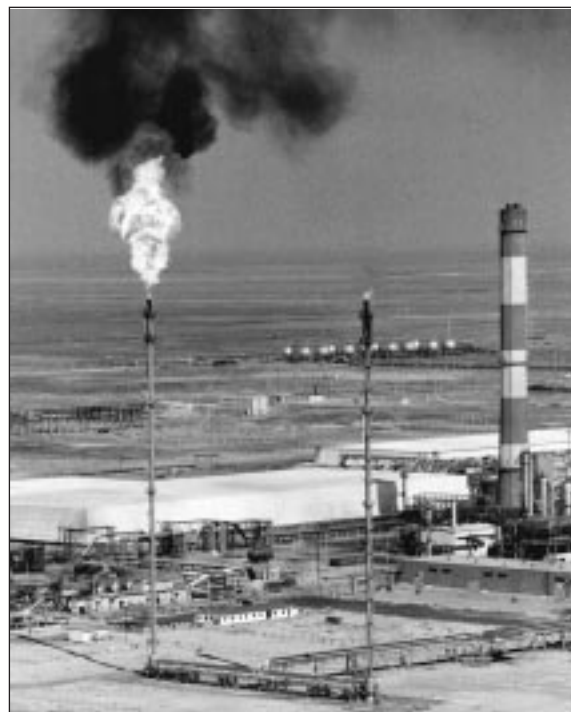
Une raffinerie de pétrole et de gaz au Kazakhstan. Une grande partie du crédit aux entreprises sert à financer l'exploitation des ressources naturelles.
