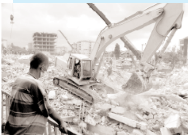
À Gölcük (Turquie), une pelleteuse enlève les restes de bâtiments détruits.
