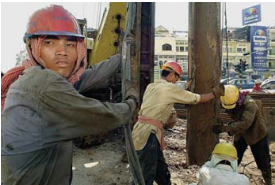
Obras en una calle de Phnom Penh.
