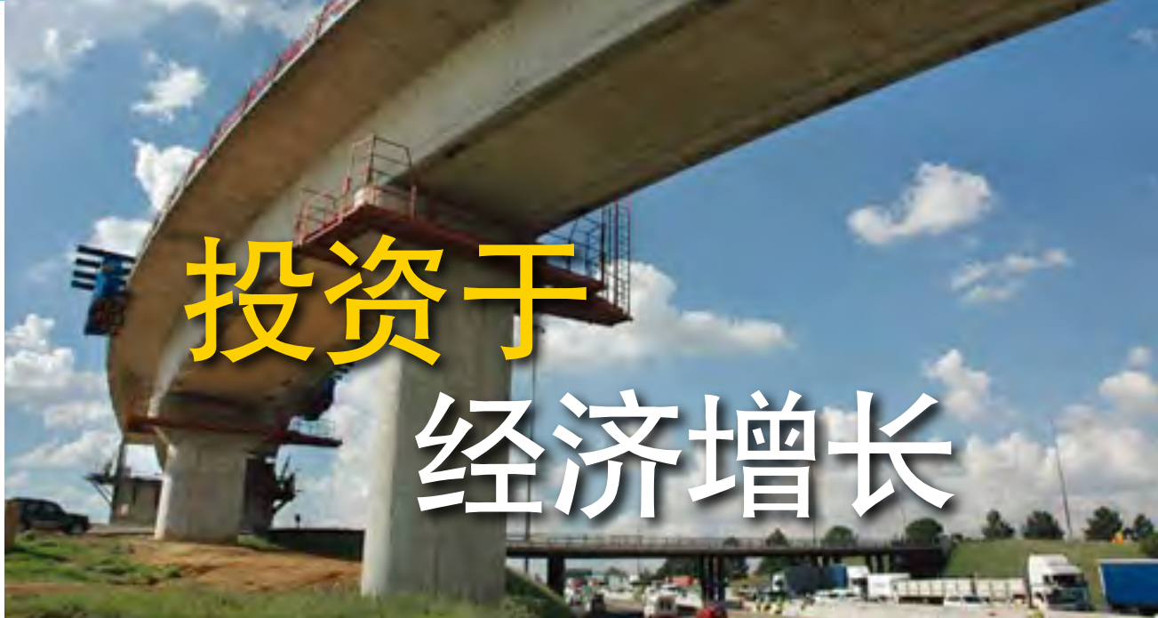
南非约翰内斯堡市的公路立体交叉桥道路建设。
